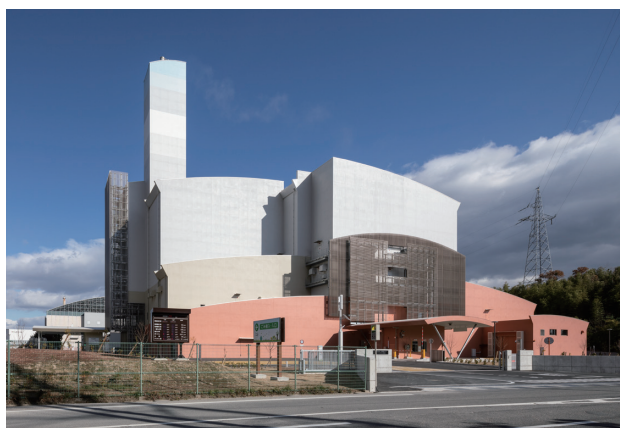
図1 桑名広域清掃事業組合 可燃ごみ焼却施設
