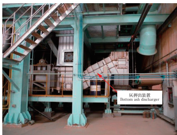
図8 灰押出装置据付
