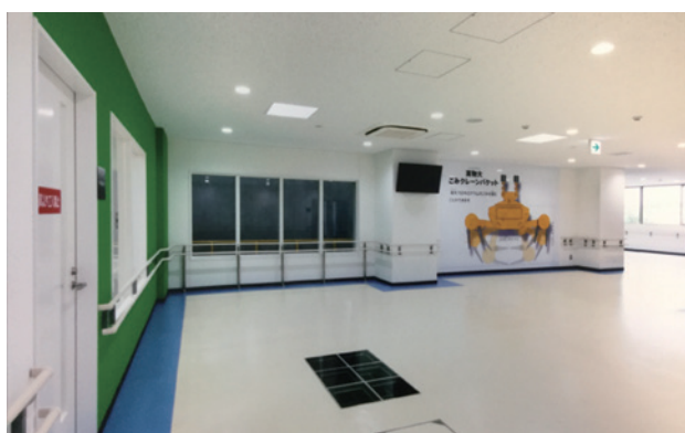
図8 光ダクト（室内照明部）
