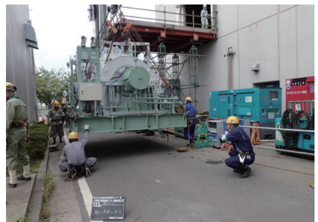
図4 蒸気タービン搬入状況
