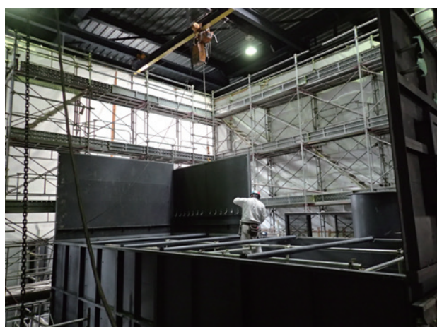
図7 バグフィルタ搬入据付状況
