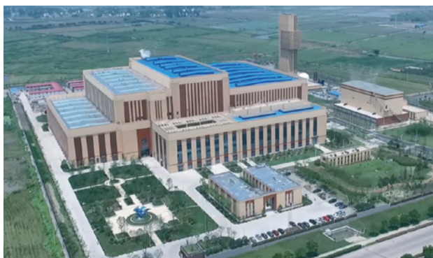
図 1 上海市松江区ごみ焼却施設
