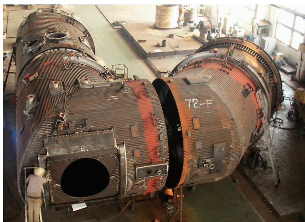
図3 大型の廃熱ボイラ仮組作業
