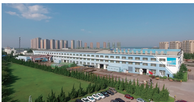
中国・青島の青島荏原環境設備有限公司。焼却炉やボイラなどの主要機器やメンテナンス時の交換部品を製造する。中国やアジアにも販売している。荏原環境プラントの100%子会社
